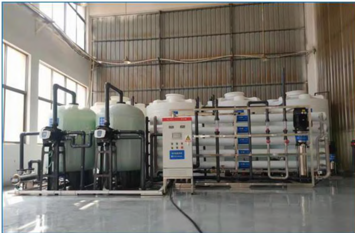
图 7.2.2-2 UF-RO 系统示意图
